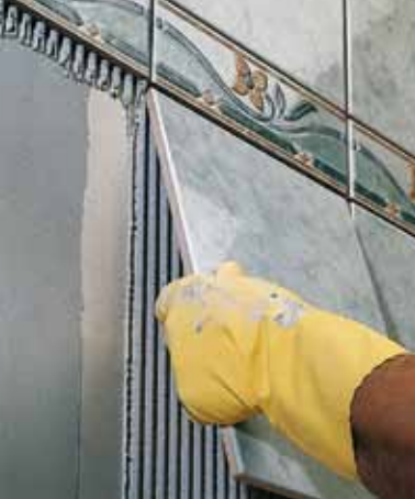
Tek pişirim seramik karonun duvar sıvası üzerine uygulanması
