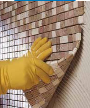
2x2 cm mermer mozaiklerin duvara uygulanması
