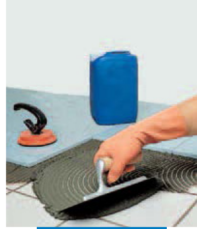
Granirapid gri ile mevcut seramik karo üzerine aglomera uygulanması
