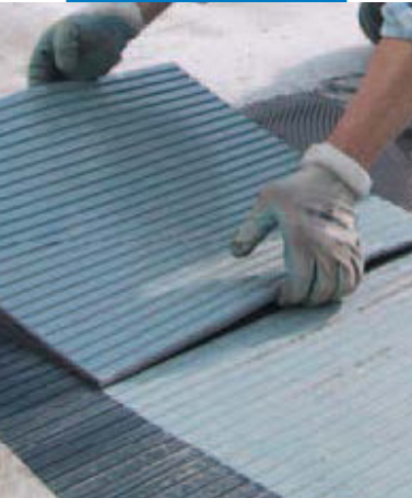
Kauçuk zemin döşemesinin, çimento üzerine Granirapid ile
