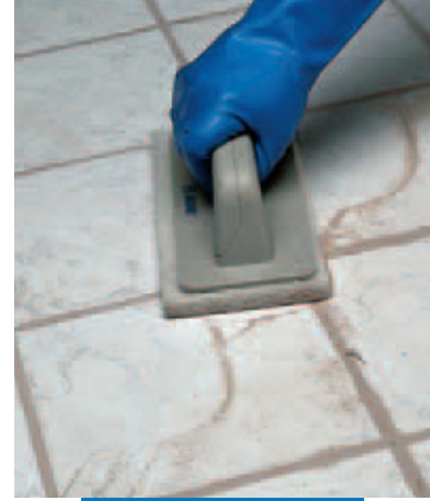
Bir Scotch-Brite® keçe ile bitirme işleminin yapılması
