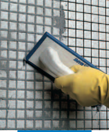
Cam mozaik'in derz dolgusunun mala ile yapılması (banyo)
