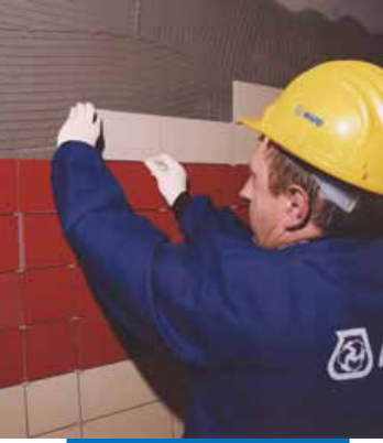
Yukarıdan aşağı doğru çalışarak duvara seramik karo uygulanması
