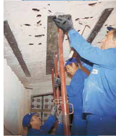
Metal plakanın yapısal güçlendirme için yerleştirilmesi
