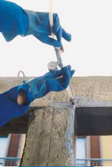
Adesilex PG1 ile kaplanmış kolon
