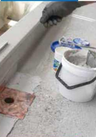
Bakır boyunlu flanş ve dren ağzını döşeme
