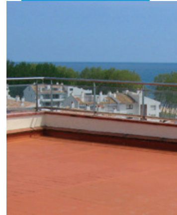
Aquaflex Roof ile su yalıtımı yapılmış teras döşemesi
