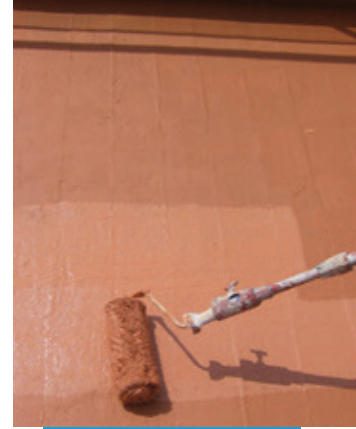
Aquaflex Roof'un uzun tüylü bir ruloyla uygulanması
