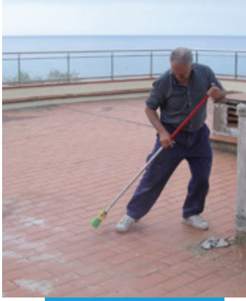
Aquaflex Roof uygulaması öncesi alt yüzey temizliği
