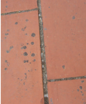
Aquaflex Roof uygulaması öncesi işlem görmesi gereken terracota zemin örneği
