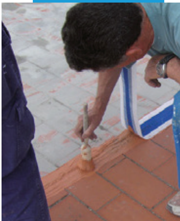
Aquaflex Roof kullanılarak yapıştırılan Mapeband ile genişleme derzinin su yalıtımı
