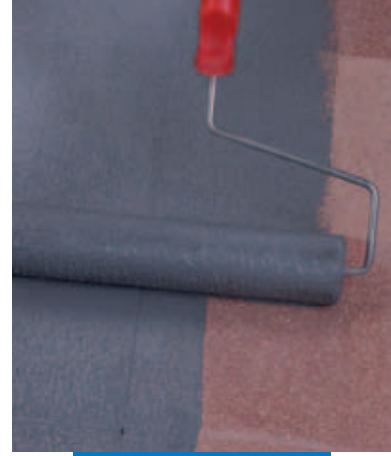
Mevcut terrazzo zemin kaplaması üzerine rulo ile Eco Prim Grip uygulanması
