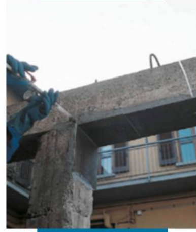
Epojet enjeksiyonuyla kırış onarımı
