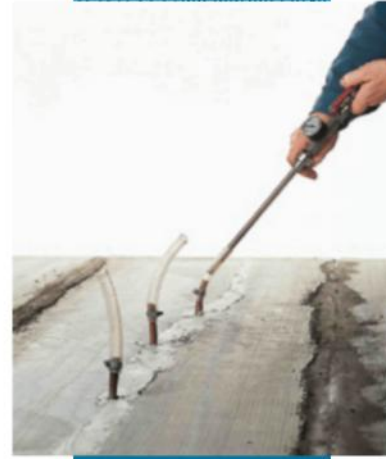
Yatay yapıyı Epojet enjekte ederek restore etme
