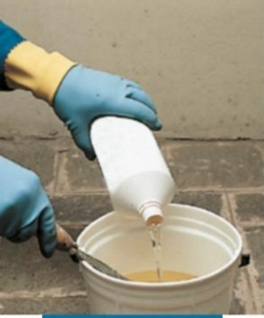
Epojet karışımını hazırlama
