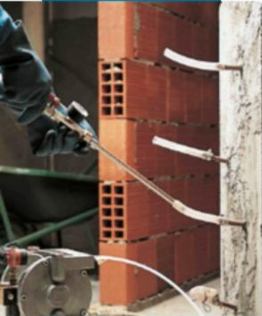
Epojet'i çatlaklı bir kolona enjekte etme
