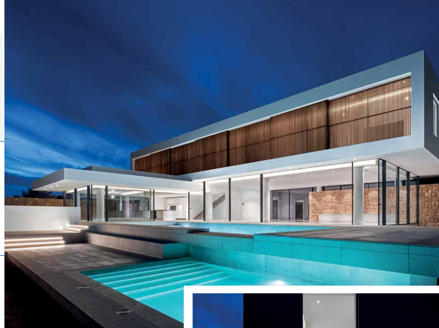
Cap Blanc Minerva / Islas Baleares, İspanya Isı yalıtımı uygulaması ve dış cephe kaplaması
