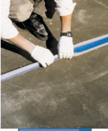
Ysı terasında genişleme derzi su yalıtımı örneği
