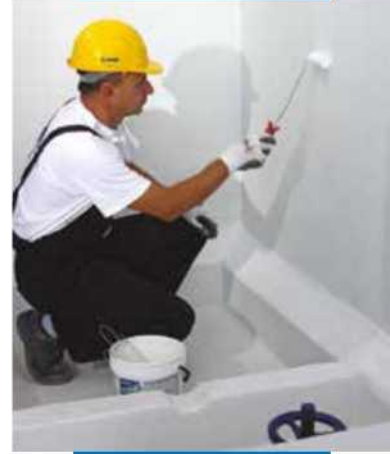
Rulo fırça ile Triblock P uygulaması
