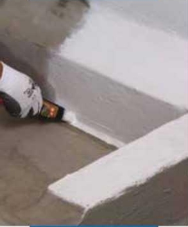
Döşeme levhası ile dikey duvar arasındaki derzi kaynaştırmak için uygulanan Triblock P
