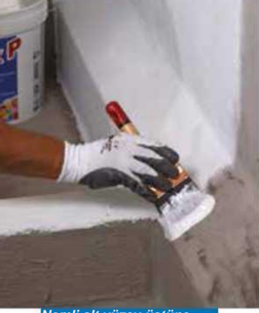
Nemli alt yüzey üstüne Triblock P fırçasıyla uygulama
