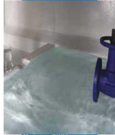
Mapecoat DW25 tamamen kurduktan sonra tankı doldurma
