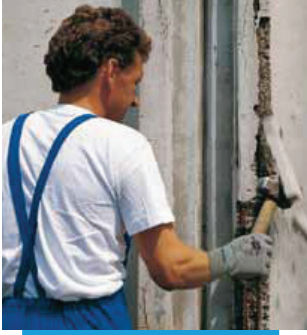
Hasarlı betonun kırımı
