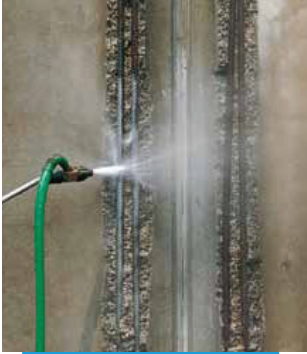
Donatı çubuklarının temizlenmesi
