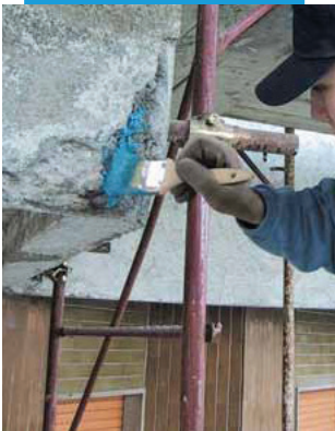
Betonarme bir balkonda donatı çubuklarına fırçayla Mapefer 1K uygulanması
