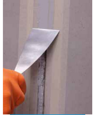
Mapeflex PU40'ı düzleştirme
