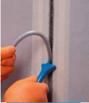
Derzin içine Mapefoam yerleştirme
