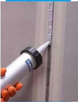
Mapeflex PU40'ın uygulaması
