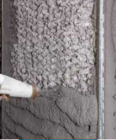
Mapegrout 430'un püskürtmeyle uygulanması
