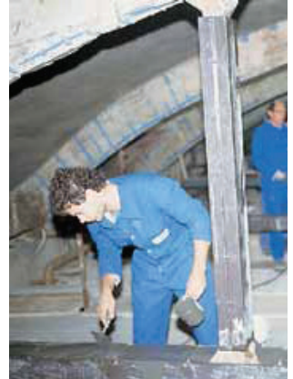
Mapegrout Hi-Flow E'nin metal kalıba dökülmesi
