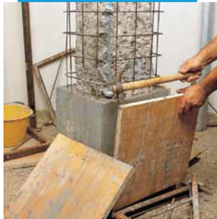
Ahşap kalıbın sökümü
