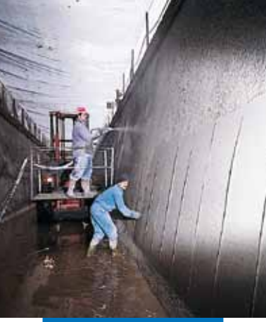
Bertini hidroelektrik kanalı - Robbiate (Como) - İtalya: mastarla bitirme
