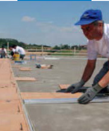
Kerabond + Isolastic ile seramik uygulaması
