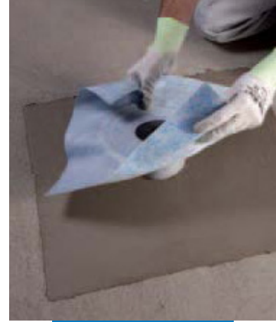
Drain Vertical'ın Mapelastıc üzerine uygulanması
