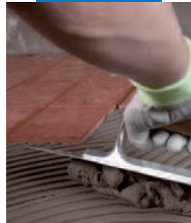
Su yalıtımı Mapelastıc ile sağlanmış bir teras Granirapid uygulanması
