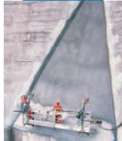
Mapelastic'in bir baraja, püskürtme ile uygulanması örneği
