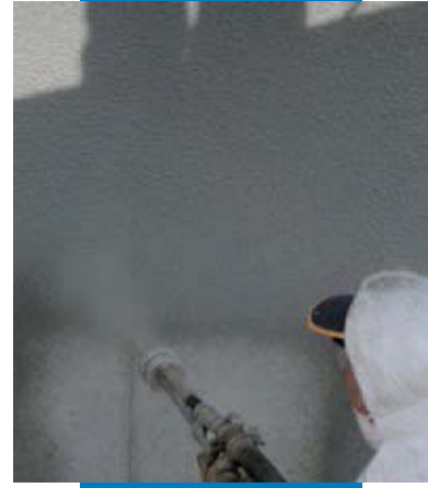
Mapelastic'in bir viyadüğe püskürtme ile uygulanması örneği
