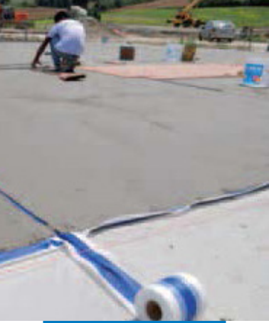
Şapların su yalıtımının Mapelastic ve Mapeband ile yapılması
