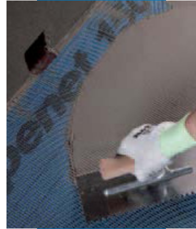
Mapelastıc'ın Mapenet 150 üzerine uygulanması
