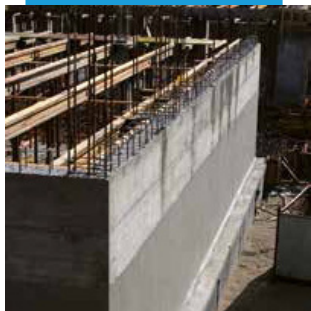
Döküm sonrası perde duvarın Mapelastic Foundation ile su yalıtımı
