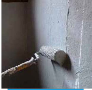
Planitop HDM Maxi ile tesviye edilmiş alt yüzeye ruloyla Mapelastic Foundation uygulanması
