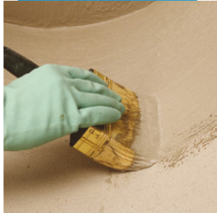
Detayların su yalıtımının fırça ile yapılması
