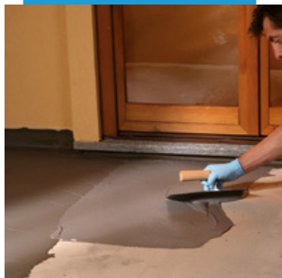
Terasların su yalıtımının mala ile yapılması
