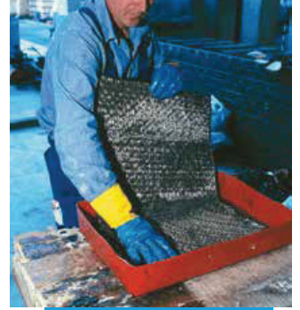
MapeWrap C kumaşın el ile empenye edilmesi
