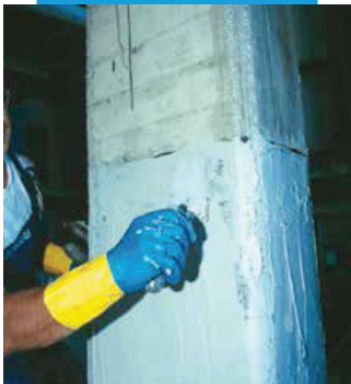
MapeWrap 11 ya da MapeWrap 12 ile yüzeyin tesviye edilmesi
