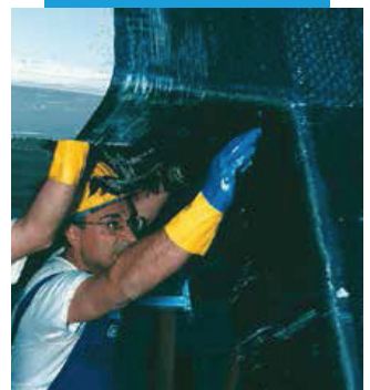
Bağlantı noktasının sarılması
