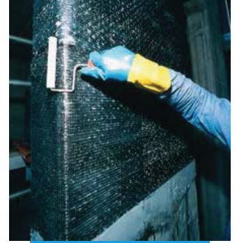
MapeWrap 31 ya da MapeWrap 31 T ikinci katının uygulanması
