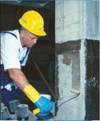
MapeWrap Primer 1'in ilk kat uygulaması
