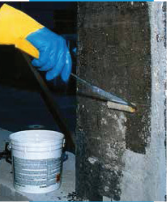
MapeWrap Primer 1'in ikinci kat uygulaması
