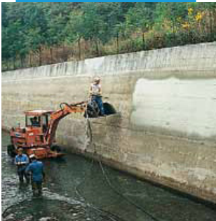
Bir hidroelektrik kanalda Planiseal 88'nun püskürtme tabancasıyla uygulanması
