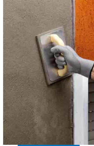
Planitop 217 yüzeyinin bitirilmesi
