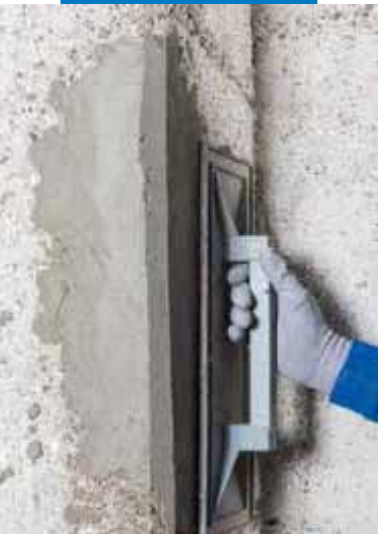
Düz bir bitiş sağlamak için Planitop Tamir & Tesviye R4 yüzeyinin mastarla düzeltilmesi
