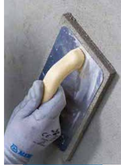
Planitop Tamir & Tesviye R4'ün yüzeyinin bitirilmesi
