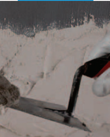
Primer AG üzerine sıva uygulanması
