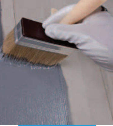
Beton üzerine fırça ile Primer AG uygulanması
