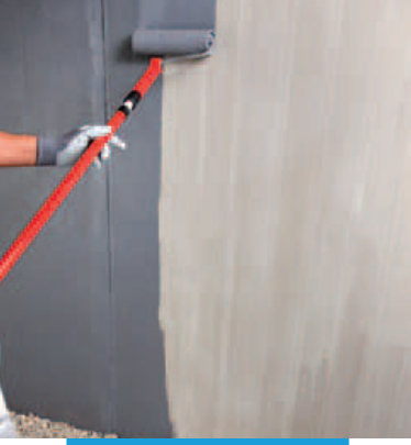
Beton üzerine rulo ile Primer AG uygulanması
