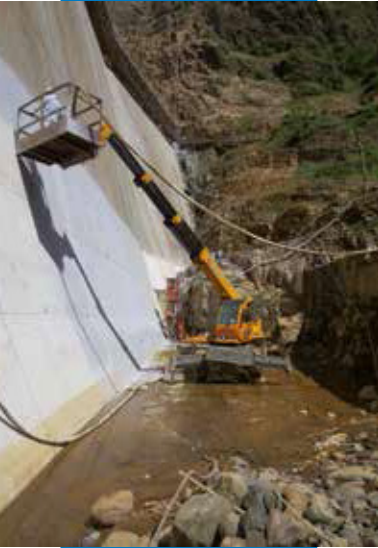
Bir barajda su yalıtım katı uygulanması
