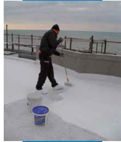
Triblock P'nin beton bir alt yüzeye rulo ile uygulanması
