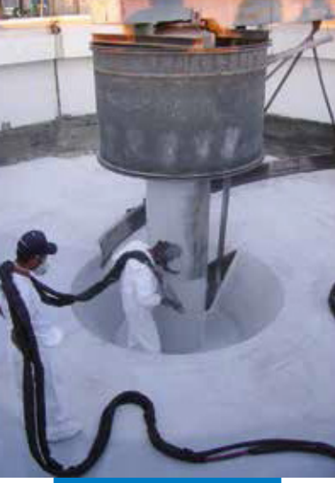
Çeşitli alt yüzeylere (çimento esaslı ve metal) uygulanmış Purtop 1000 su yalıtım katı detayı
