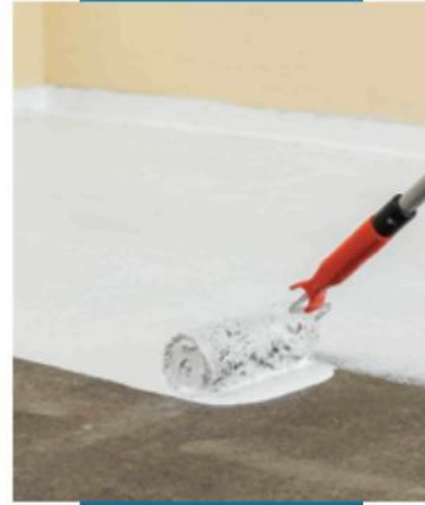
Çimentolu şapa ilk kat Aquaflex Roof Premium'un uygulanması
