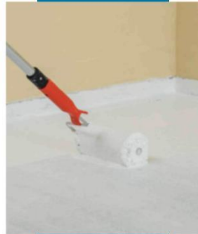
İkinci kat Aquaflex Roof Premium'un uygulanması
