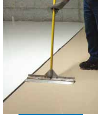
Ultratop'un yayıldıktan hemen sonra düzeltilmesi
