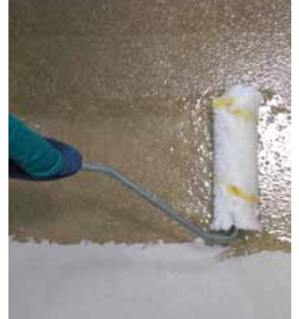
"Terrazzo" görünümü. Mapefloor I 910 uygulaması
