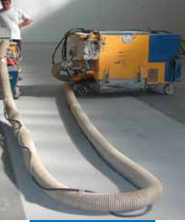
Alt yüzeyin shot-blast yöntemiyle hazırlanması
